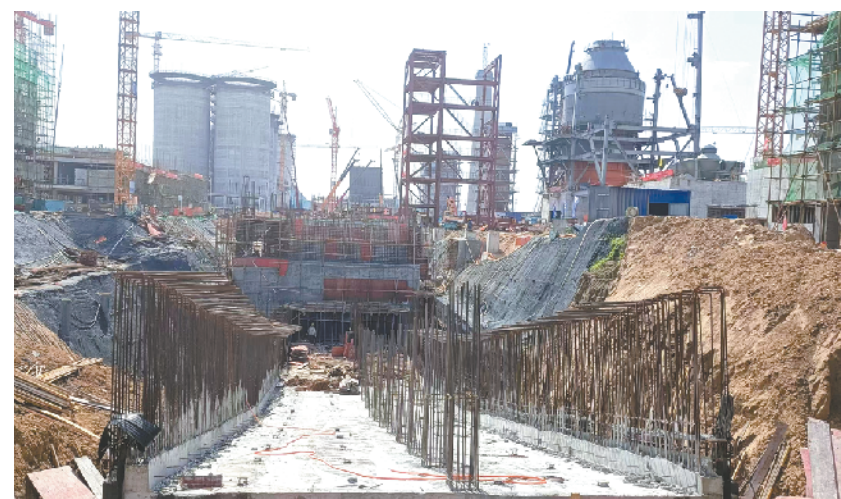
正在建设中的周钢焦化项目
