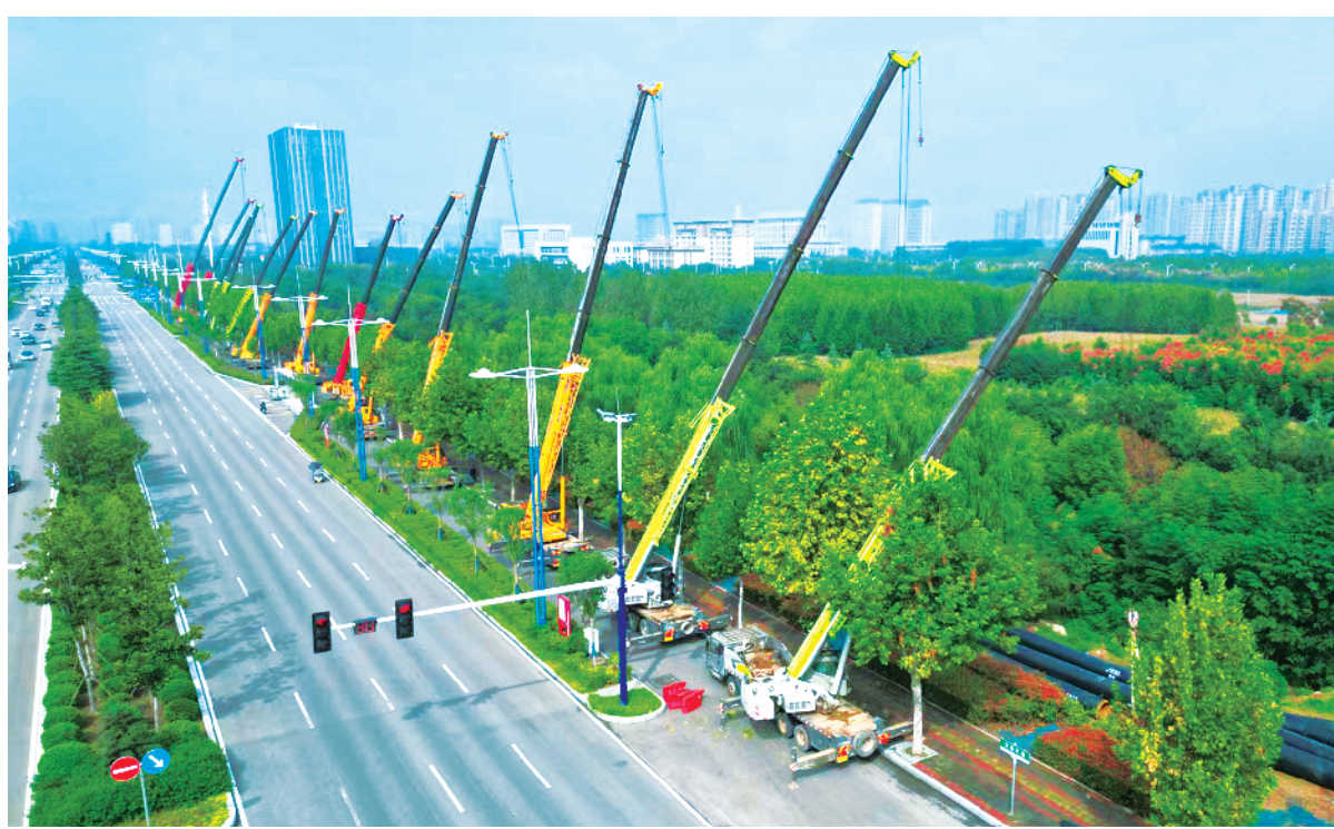
“双节”期间,在中心城区文昌大道上,13台吊机一起同步吊装数百米长的热力管道,开展热力管网建设,场面甚为震撼。热力管网铺设是今年市中心城区建设的重要民生工程。记者 梁照曾 摄
