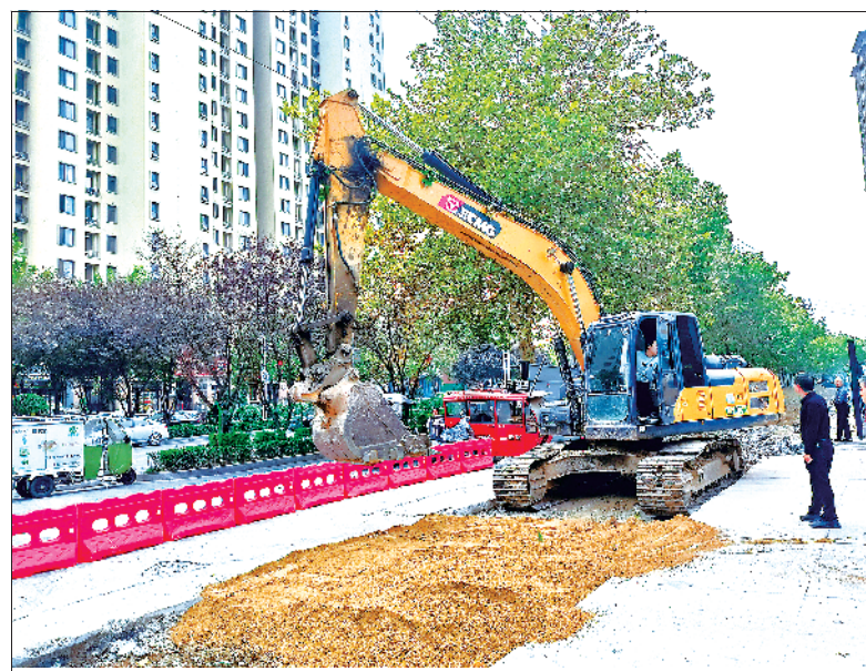
11月4日,市集中供热项目各区域施工点抢抓施工有利时机,加班加点全力推进供热首站、中继泵站和主干管网建设工作。记者 沈湛 摄
