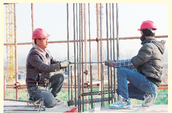
连日来,太康县坚持“项目为王”不动摇,扎实推进项目建设,为县域经济发展注入源源不断的动力。图为水星家纺产业园项目建设现场。 记者 张洪涛 摄
