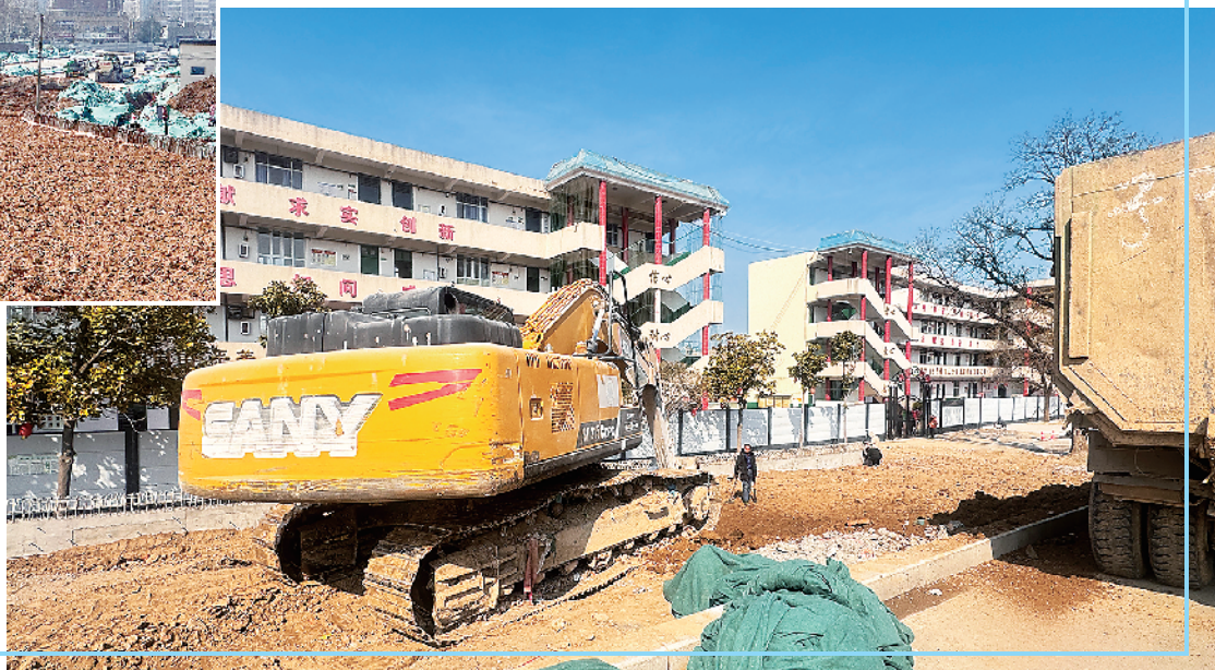
2月25日,记者在周口中心城区文昌大道西延工程施工现场看到,工人们正驾驶挖掘机紧张工作。据了解,文昌大道西延工程呈东西走向,起点中州大道,终点汉阳路,双向六车道,全部完工后可有效提升中心城区道路通行能力。记者 杜营营 摄
