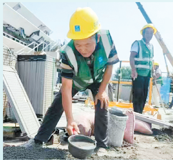
施工人员对地面进行硬化处理。
