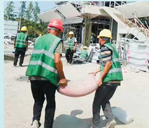
施工人员搬运水泥。
