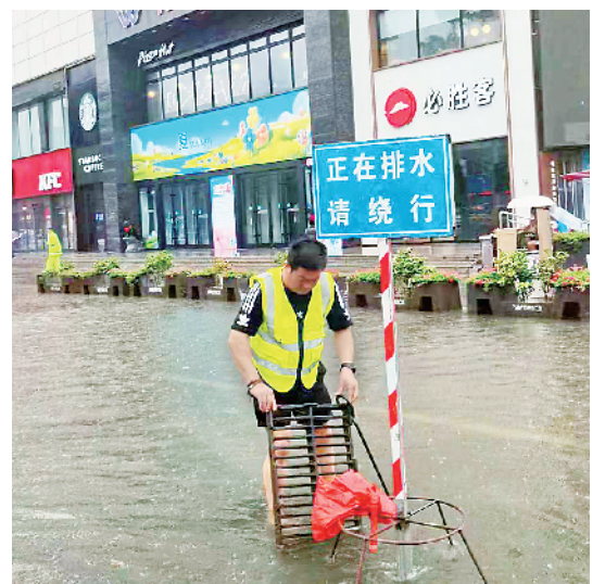
防汛突击队员在排除万顺达广场门前积水。
