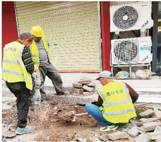
施工人员对小区污水管道进行施工。
