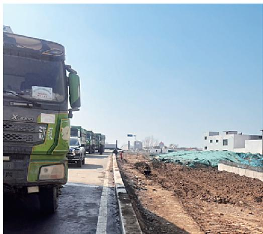
2月25日,记者在中心城区文昌大道西延工程施工现场看到,该工程正在紧张施工中。据了解,文昌大道西延工程为新建工程,起点中州大道,终点汉阳路,双向六车道,沥青混凝土路面。该工程完成后,将显著提升该区域的道路通行能力,为居民出行带来更多便利。
