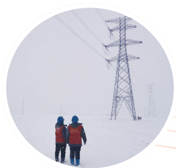
2023年冬季,国网扶沟县供电公司女子巡线队队员巡视110千伏鸿廉线第22基基座状况。刘滨 摄
